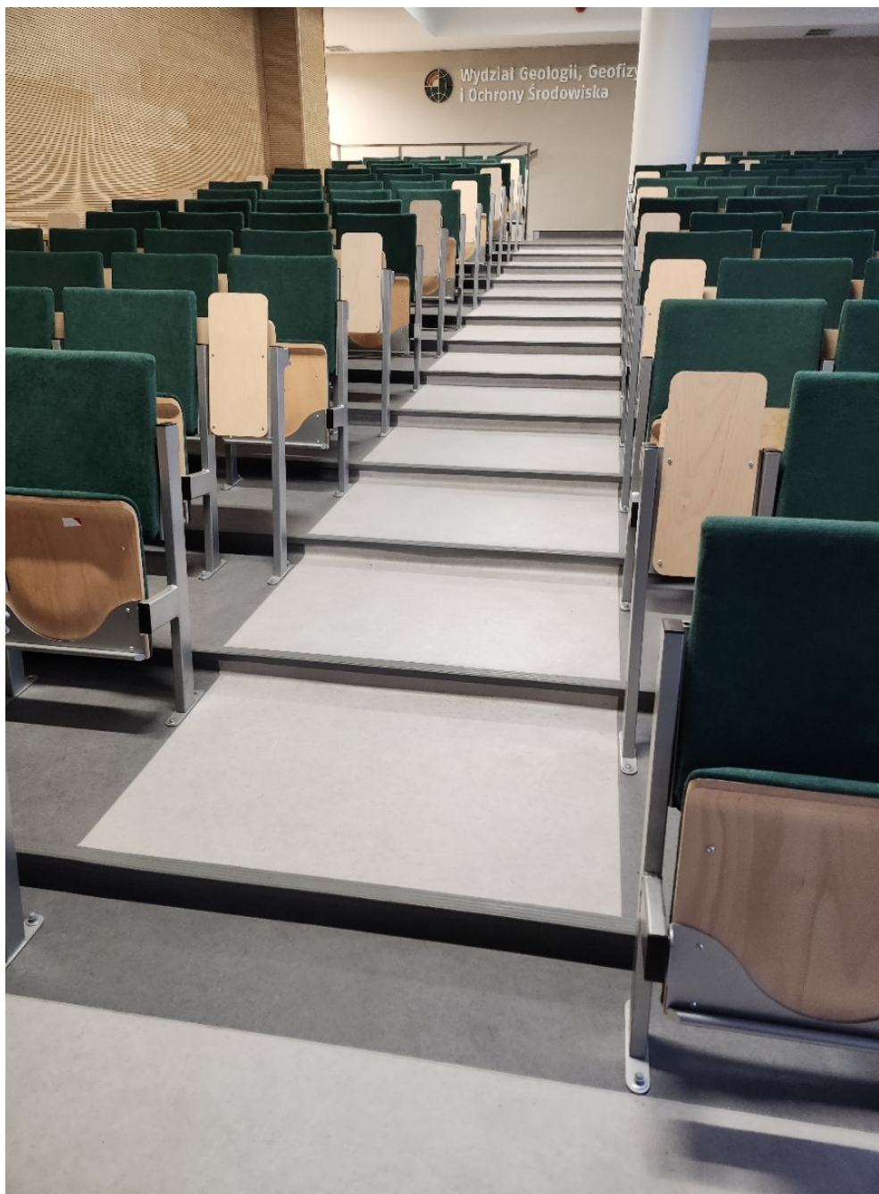
Rysunek 57. Zdjęcie oznaczenia schodów w audytoryjnej sali wykładowej w budynku A-0 AGH
