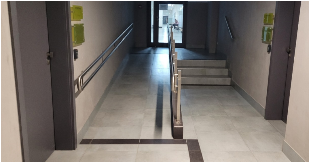
Rysunek 50. Zdjęcie drogi ewakuacji do sąsiedniego budynku
