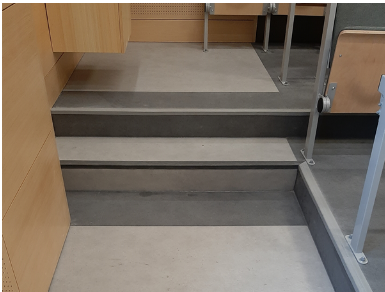
Rysunek 56. Zdjęcie przykładowego oznaczenia schodów w sali wykładowej
