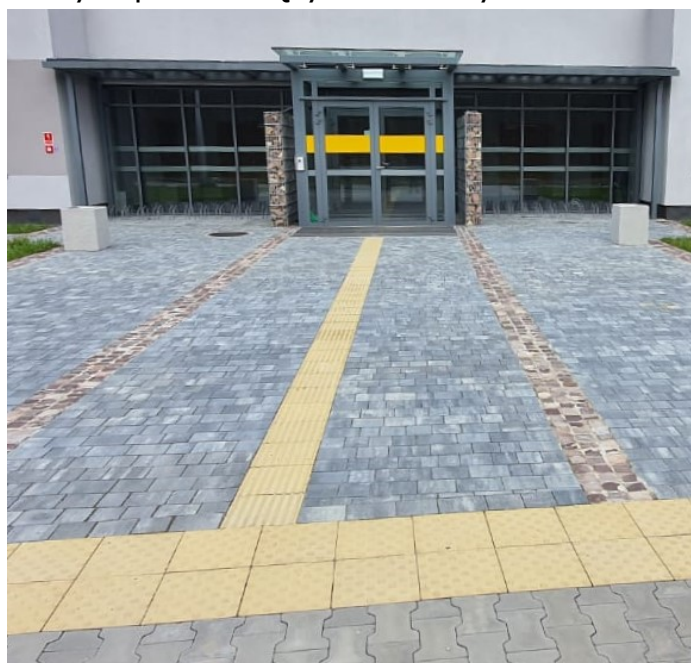
Rysunek 9. Zdjęcie elementów systemu FON przed wejściem do budynku Centrum Zrównoważonego Rozwoju i Poszanowania Energii AGH w Miękinii
